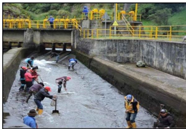
Fotografía N° 45 Mantenimiento de la Central hidroeléctrica Alao
