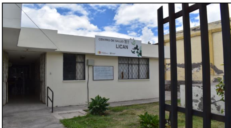
Fotografía N° 29 Centro de salud de Licán
